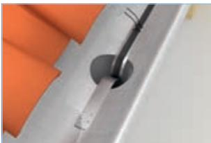
**Kantenschutz** am Fallrohr zur Zugentlastung.
